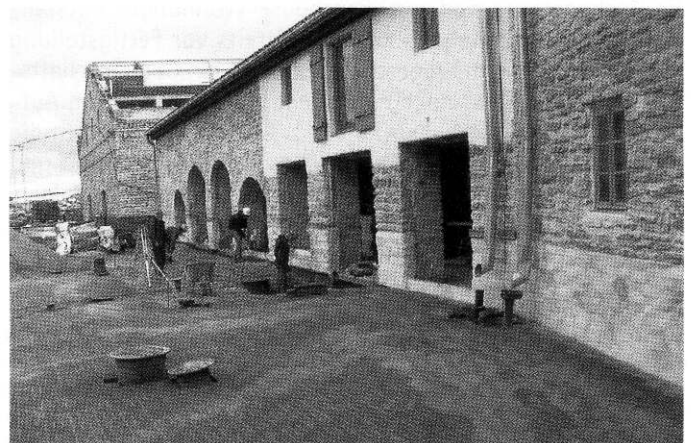
Nach der Mauerwerksanierung wurde das Areal sorgfältig gepflastert.
