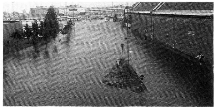
Die Hafnpromenade wird immer wieder überschwemmt.
